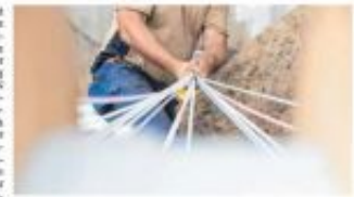
Für die Fußballveranstaltung wurden in den Städten mehrere Kilometer an Glasfaserkabel neu verlegt. FOTO: SÜDDIGITAL
