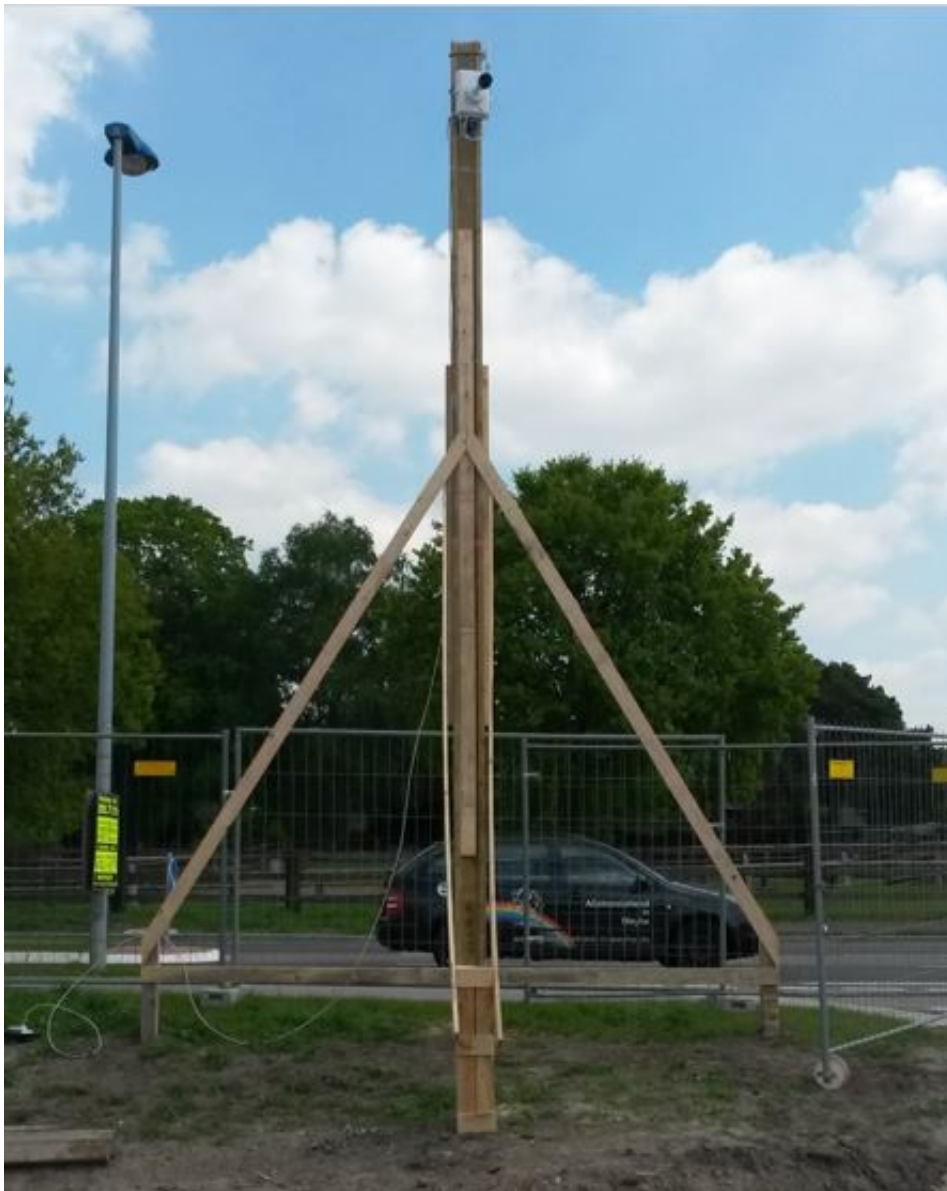
Abbildung 1 Baustellenkamera am Mast
